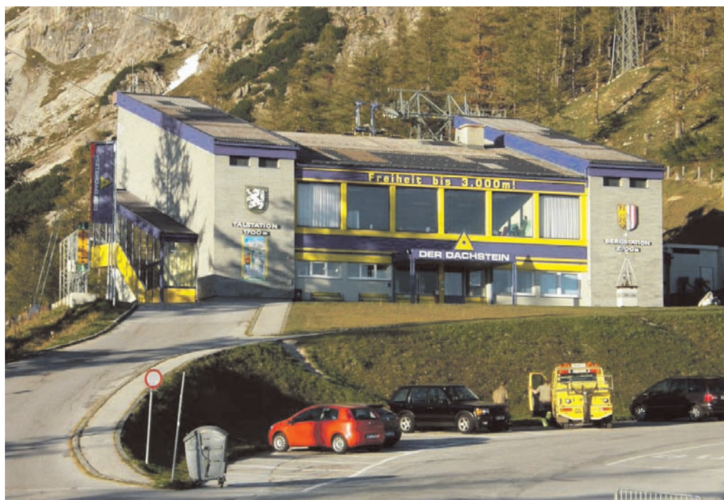
Unter dem Schutz der UNESCO: Die Talstation der Dachsteinbahn in der Welterbe-Kulturlandschaft Hallstatt-Dachstein/Salzkammergut.
