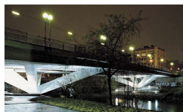
Die 91,39 Meter lange und 26 Meter breite Rossauerbrücke wird an beiden Uferseiten von je vier Pfeilern in Form einer auf dem Kopf stehenden Pyramide getragen
