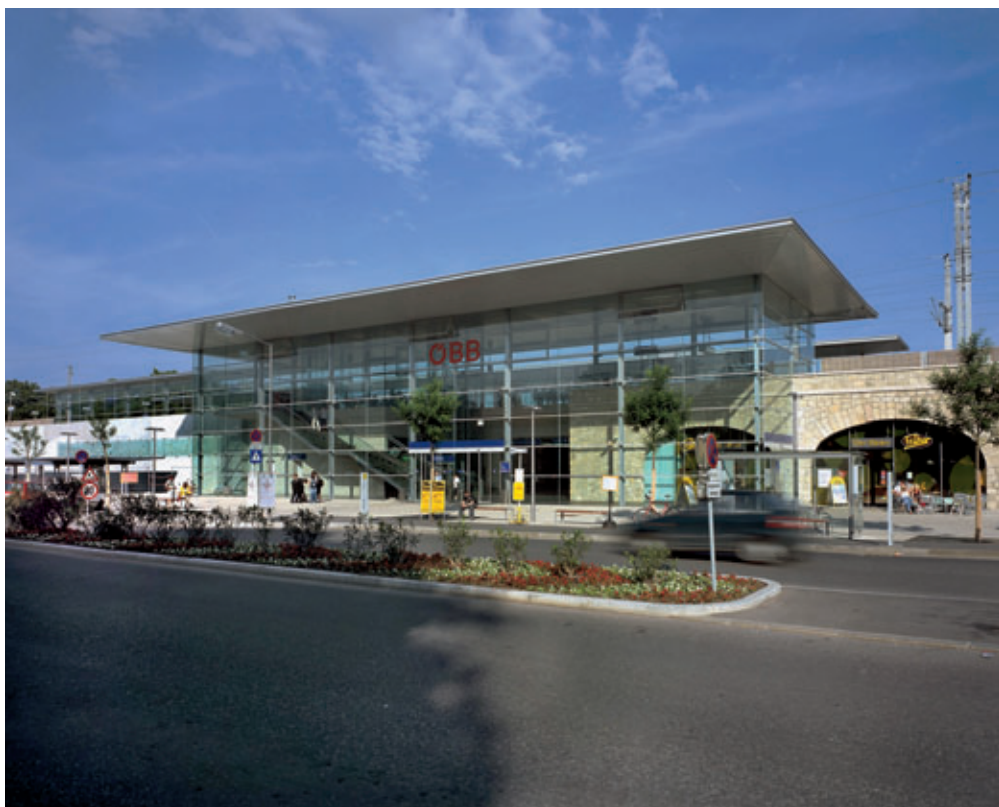
Bahnhof Baden (Architekten Henke und Schreieck, Wien; Statik: Gmeiner Haferl, Wien)
