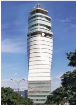
Flughafen Tower Wien Schwechat
