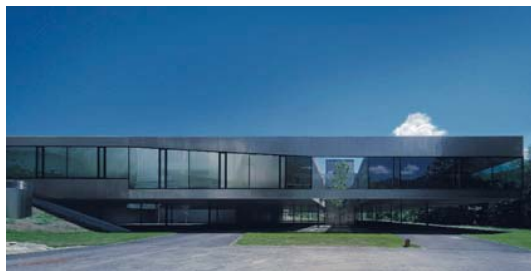
Verwaltungsgebäude Travel Europe, Stans
