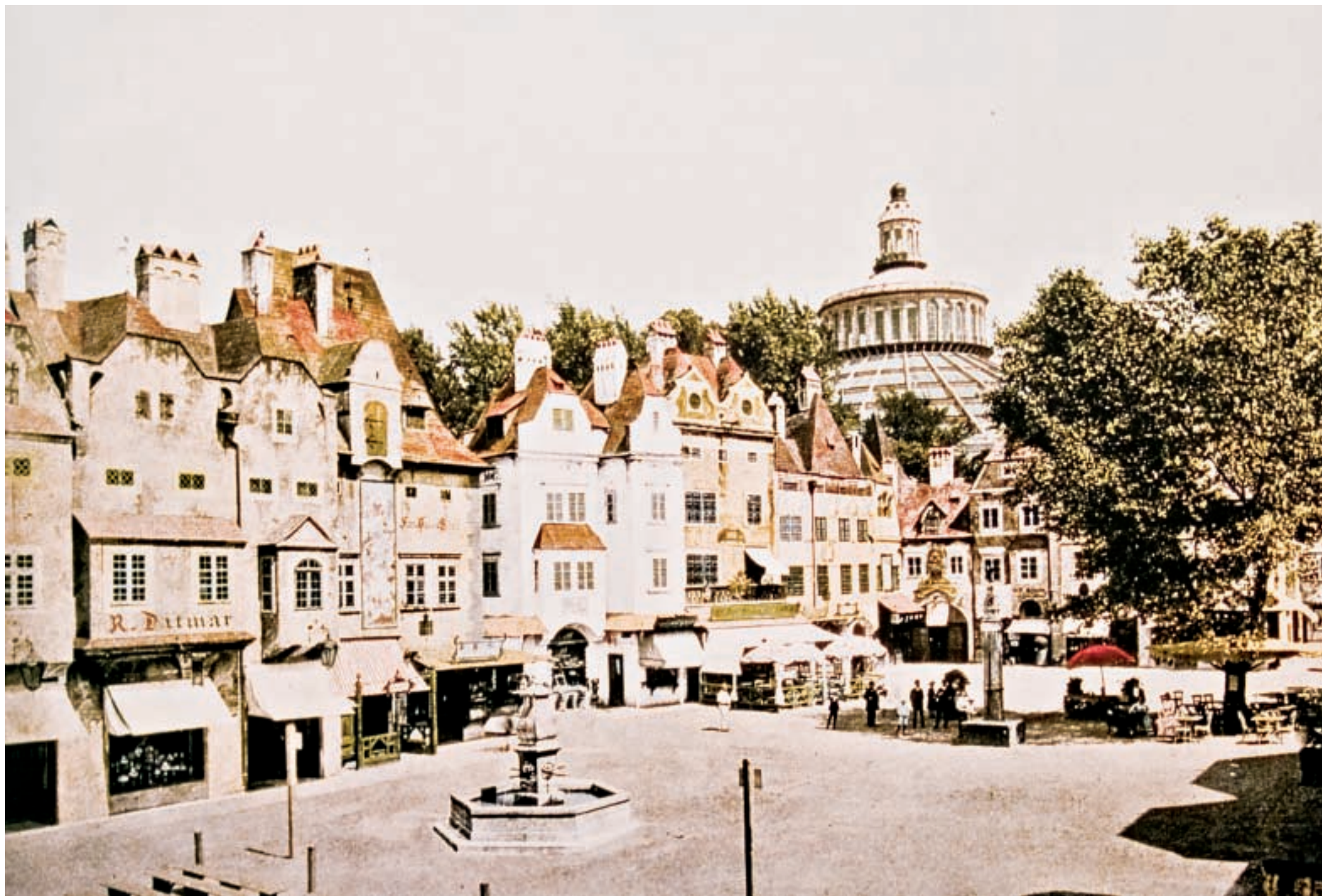
Die Biedermeier-Fassadenkonstruktionen während der Weltausstellung im Jahre 1873 auf dem Pratergelände – auch damals gab es schon Themenparks.
