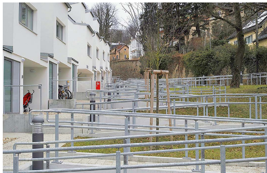
Aus „Form folgt Paragraph“: Gestaffelte Reihenhäuser als Erweiterung der bestehenden Anlage überwinden acht Meter Höhenunterschied. Für diese Bebauungsform ist eine barrierefreie Erschließung (6%-Rampe) gesetzlich vorgeschrieben. Stadt des Kindes, 1140 Wien, Architektur: Walter Stelzhammer, Peter Weber.
