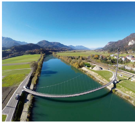
Geh- und Radwegbrücke Puch
