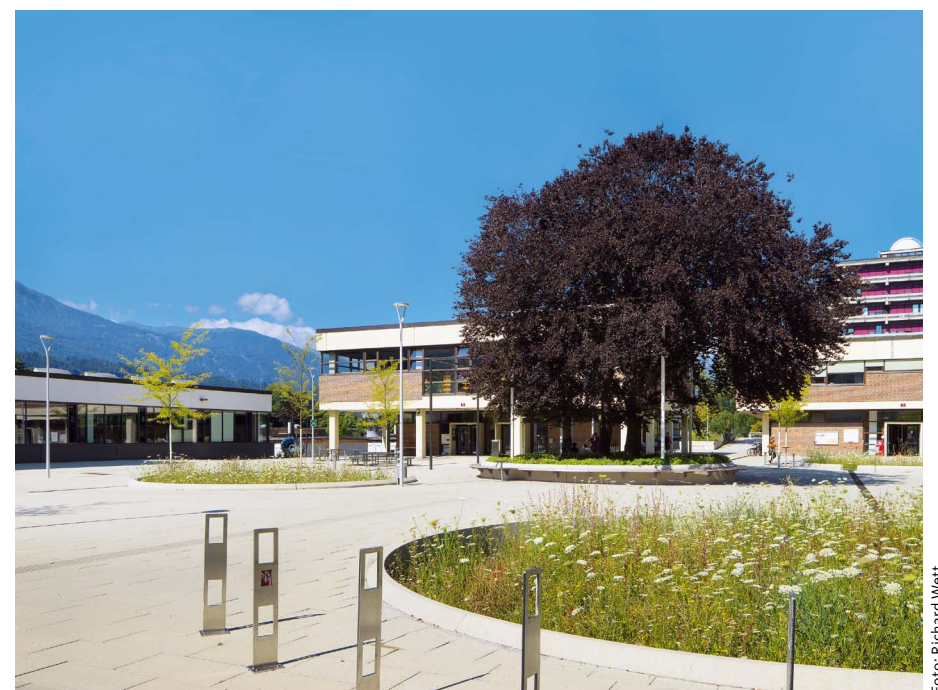
Tiefbeete zur Regenwasserversickerung am Campus Technik, Innsbruck; Planung: Karl Grimm, Auftraggeber: BIG
